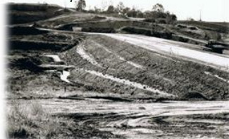
Photos prise lors des travaux
