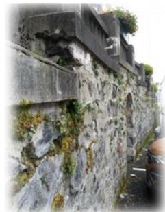
Des problèmes de sécurité des usagers et de fragilité des ouvrages nous imposent de réaliser ces travaux en urgence pour éviter la survenue des accidents. (risque de chute de pierres et d'effondrement de la rambarde béton de la Place Malègue et du parapet du pont du Buisson)
