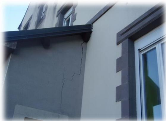
L'ouvrage est « fondé » dans le remblai du mur de soutènement et donc non conforme aux règles de la construction et la hauteur des fondations non réglementaires vis-à-vis de la mise hors gel. Après consultation du dossier de 1997, il n'y avait pas eu d'étude de sol réalisée en amont des travaux.
